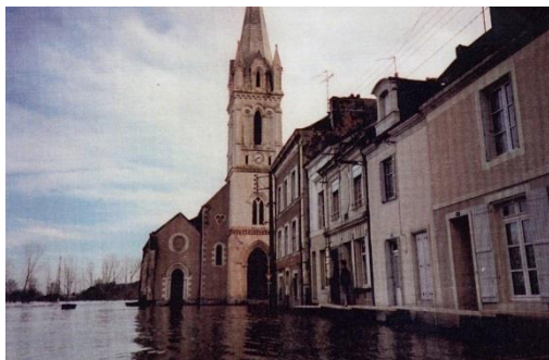
Crue de janvier 1994, église Saint-Maurille
