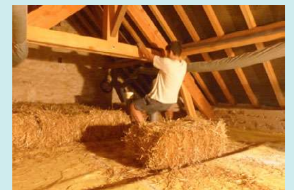
Exemple d'isolation en botte de paille (Source : PNR Brenne)
